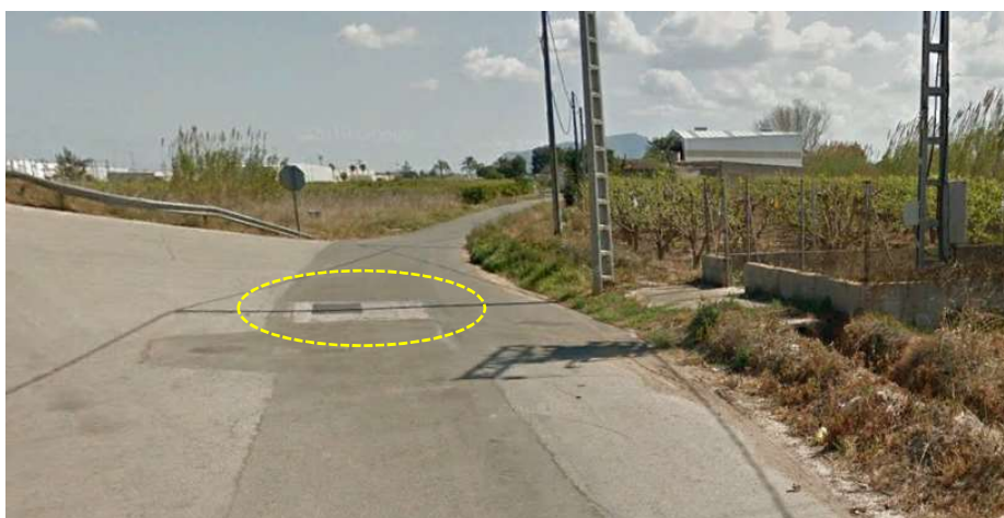
Imagen 4. Vista arqueta con brida DN 800 para conexión.
