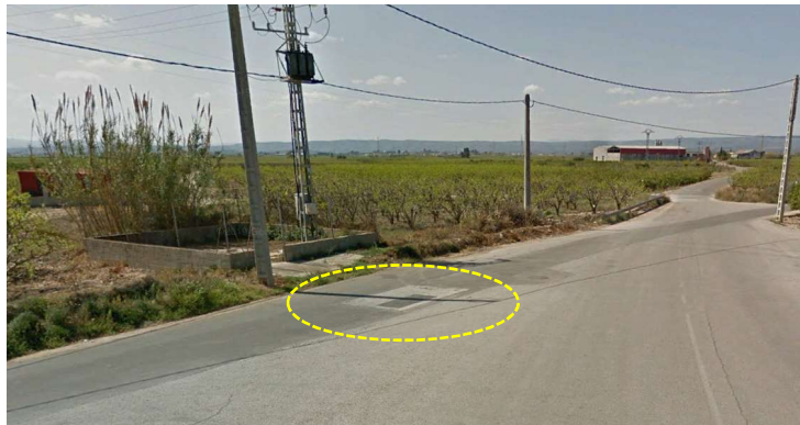
Imagen 2. Arqueta existente inicio conducción de transporte sectores 12 y 13.
