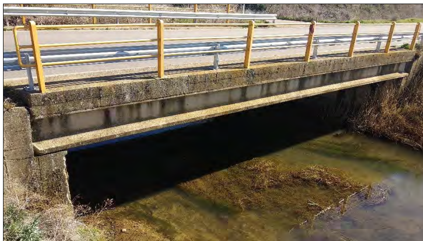
Ilustración 288.- Puente de la carretera LE-6517 sobre el Arroyo Valdearcos.
