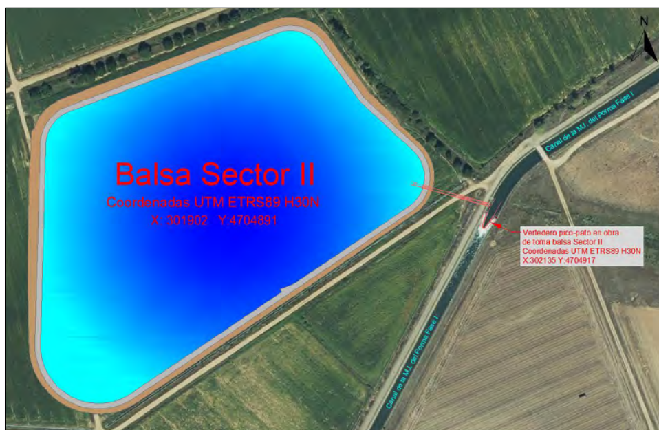
Ilustración 235.- Balsa, obra de toma y vertedero pico-pato del sector II.
