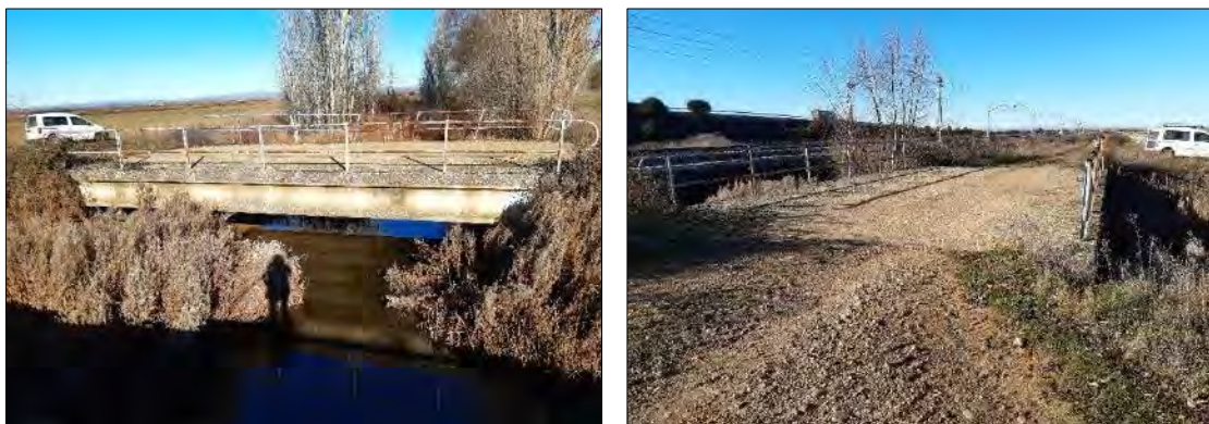
Ilustración 254.- Puente del camino agrícola 1 sobre el Arroyo Valdearcos.
