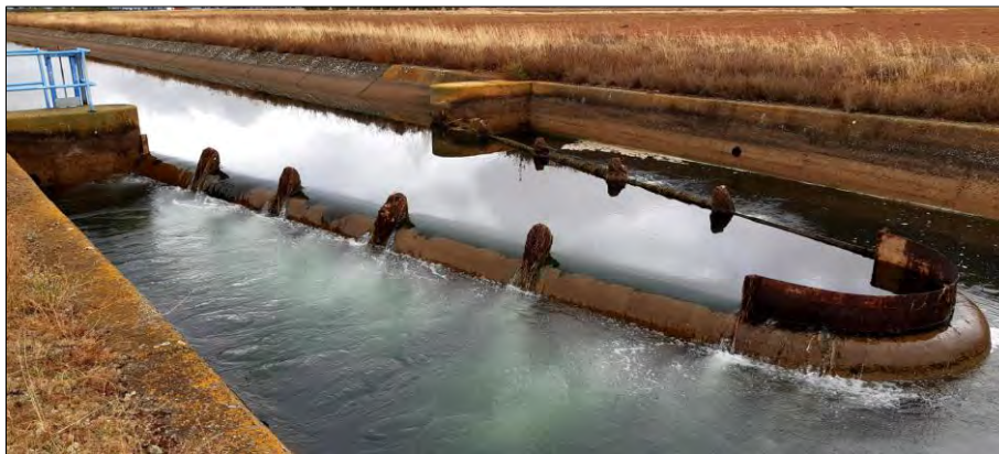
Ilustración 24.- Vertedero pico-pato aguas abajo de la futura obra de toma del sector III.
