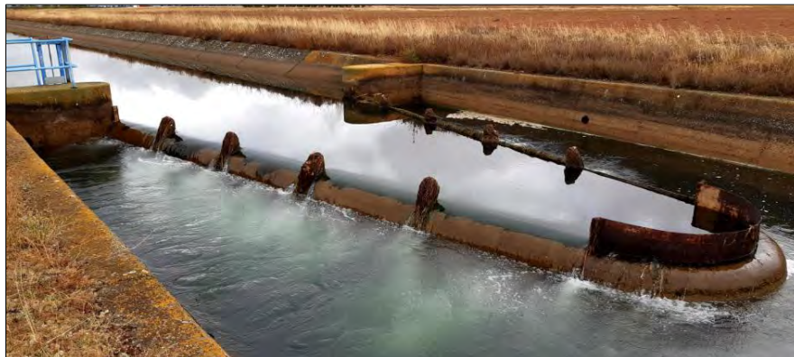
Ilustración 273.- Vertedero pico-pato aguas abajo de la futura obra de toma del sector III.
