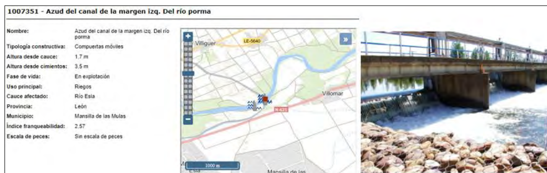
Ilustración 3.- Azud de Villomar en el río Porma (1007351) para el Canal de la MI del Esla, 1ª Fase, tramo Esla. Fuente: web Mírame-IDEDuero de C.H.D.
