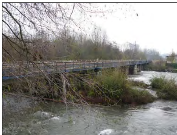
Ilustración 182.- Pasos de la vía férrea Palencia - La Coruña en el término de Villanueva de las Manzanas (Fuente: Inventario de la JCyL).
