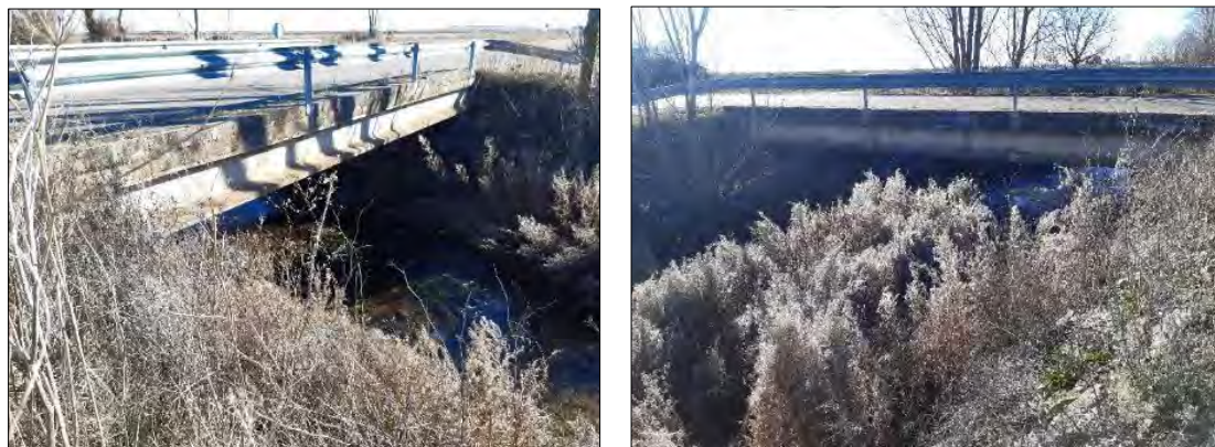
Ilustración 284.- Puente de la carretera LE-6605 sobre el Arroyo Valdearcos.
