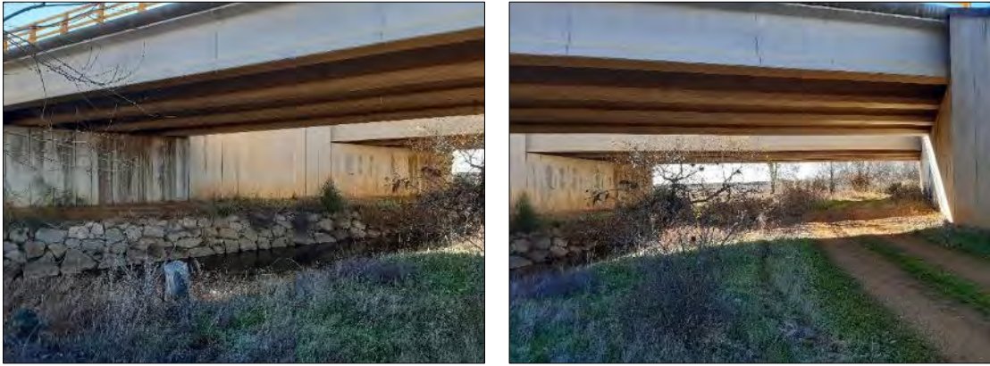
Ilustración 251.- Puente de la autovía A-231 sobre el Arroyo Valdearcos.
