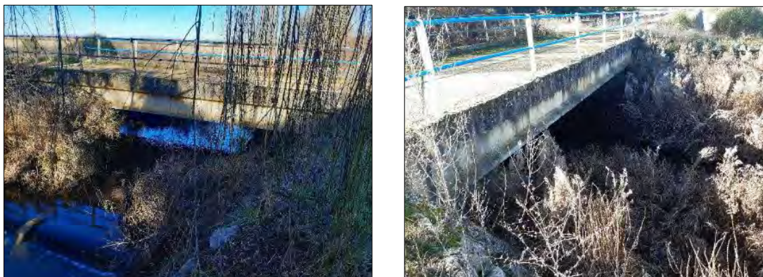
Ilustración 257.- Puente del camino agrícola 2 sobre el Arroyo Valdearcos.
