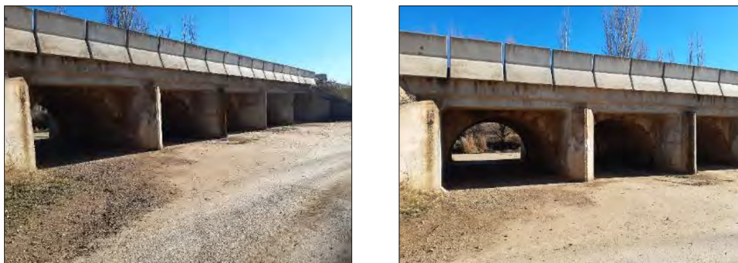
Ilustración 286.- Puente de la carretera LE-512 sobre el Arroyo Valdearcos.
