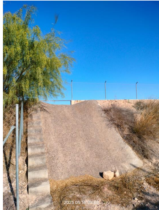
En esta imagen se visualiza el aliviadero existente, se demolerá y renovará la parte horizontal, y se mantendrá la parte del talud (al estar en buen estado).
