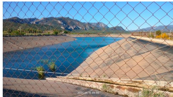
En esta imagen se visualiza el vaso del embalse, donde se ven los lastres entrada (a demoler) y la obra de entrada (a demoler) con las aguas procedentes del sondeo, y la lámina impermeabilizante EPDM existente (a desmontar).
