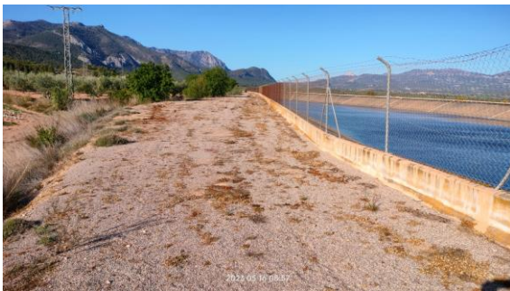
En esta imagen se visualiza la coronación del dique, con un ancho variable.
