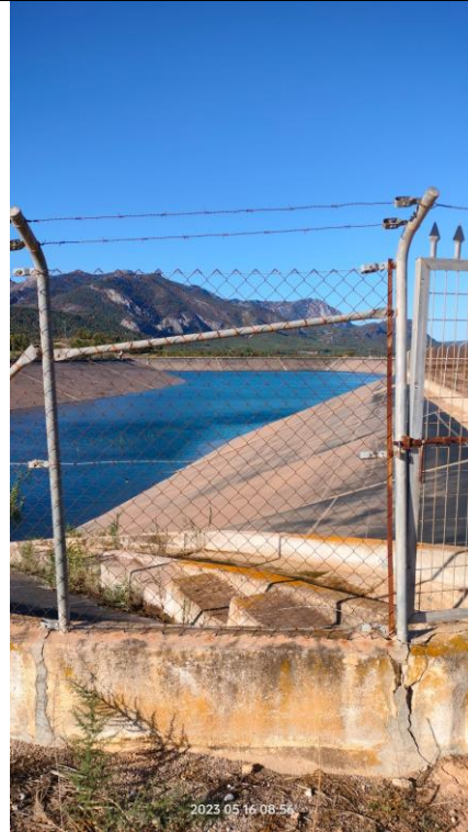
En esta imagen se visualiza la obra de entrada (a demoler) con las aguas procedentes del sondeo, el vallado perimetral (a demoler) y una puerta de acceso (a demoler).
