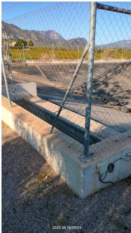
En esta imagen se visualiza la arqueta de rotura de la entrada de agua procedente del TTS, se realizará la adaptación de esta arqueta con la lámina nueva a instalar.
