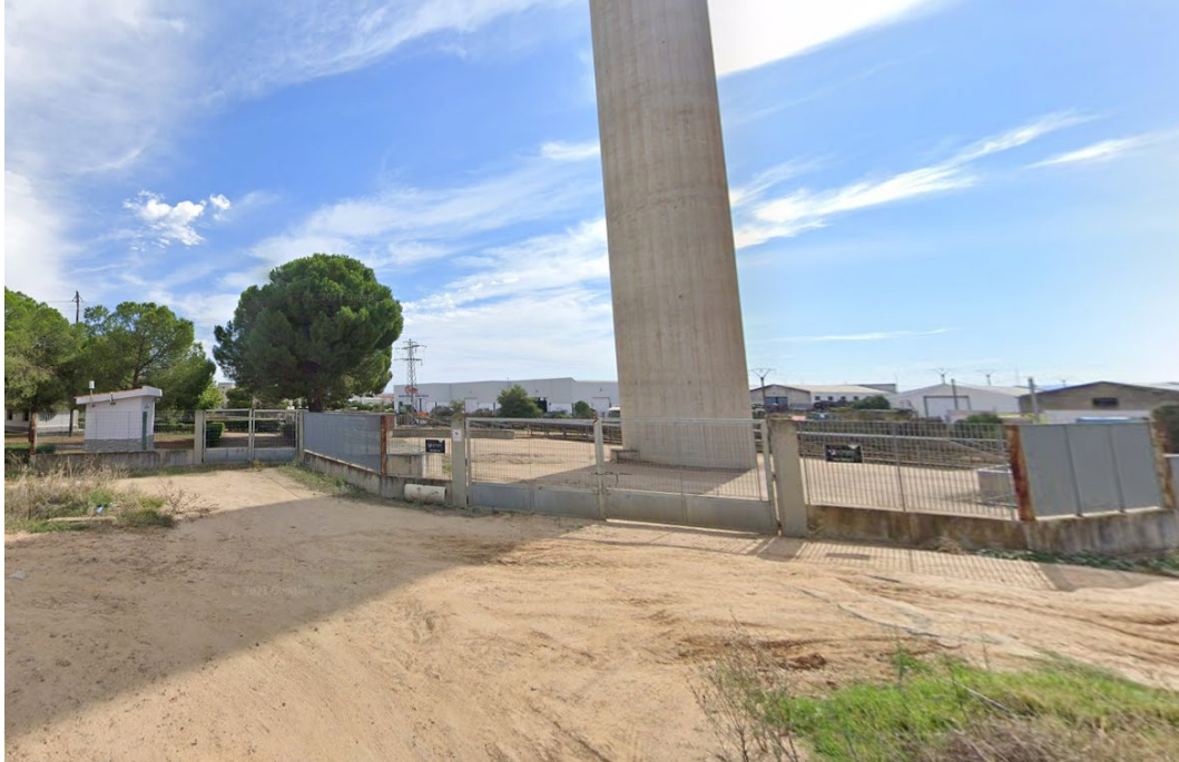
Fotografía 3. Acceso a zonas acopio sector III-IV
