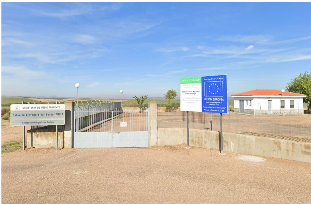
Fotografía 5. Acceso a casetas de obra sector VIII.2
