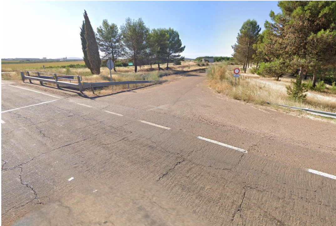
Fotografía 4. Acceso a carril de servicio desde EX-105
