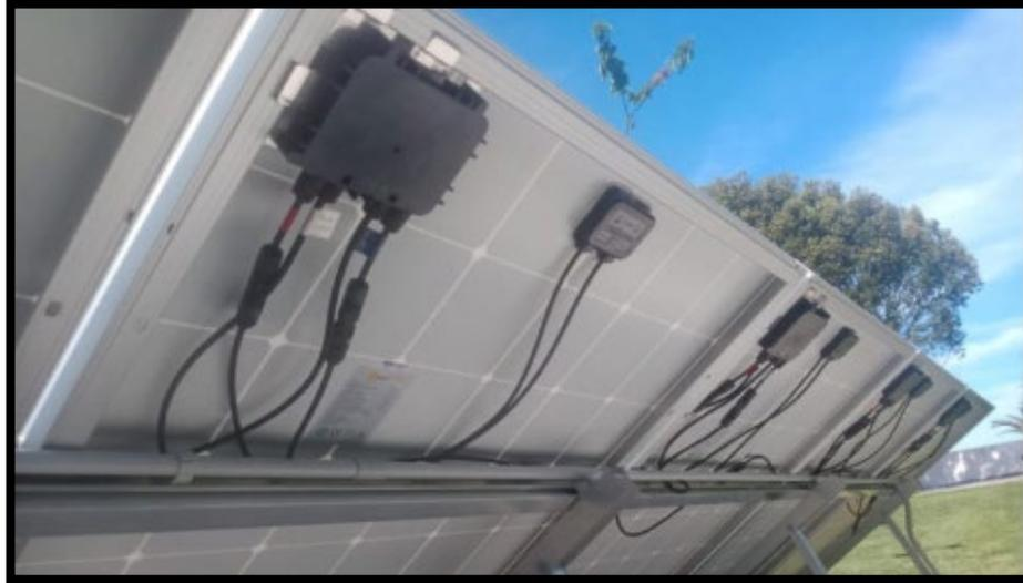
Los strings, ya conectados, se conectan con a los inversores situados a pie de estructura. Estas conexiones se llevan a cabo con cables de  $6 \text{ mm}^2$  para evitar superar la caída de tensión permitida por el REBT (1,5 %).
