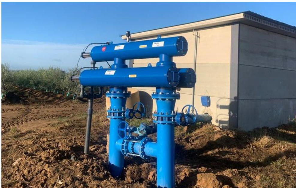
*Imagen 2. Cabezal de filtrado sobre red de riego de la comunidad*
