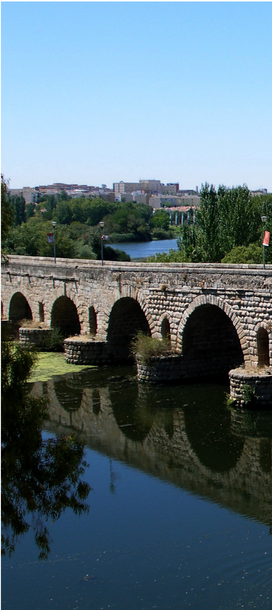
Puente de Mérida
