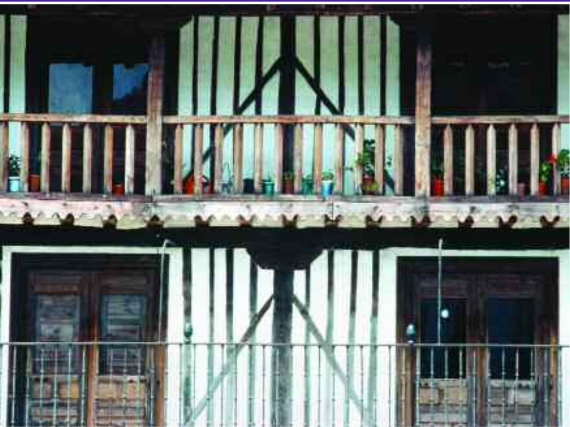
Bellas estructuras antiguas en fachadas de La Alberca (Salamanca).
