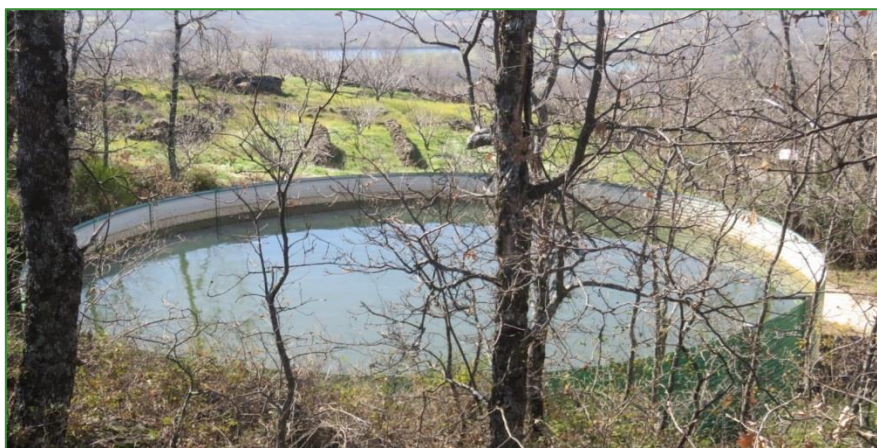
Imagen 1: Depósito de chapa
