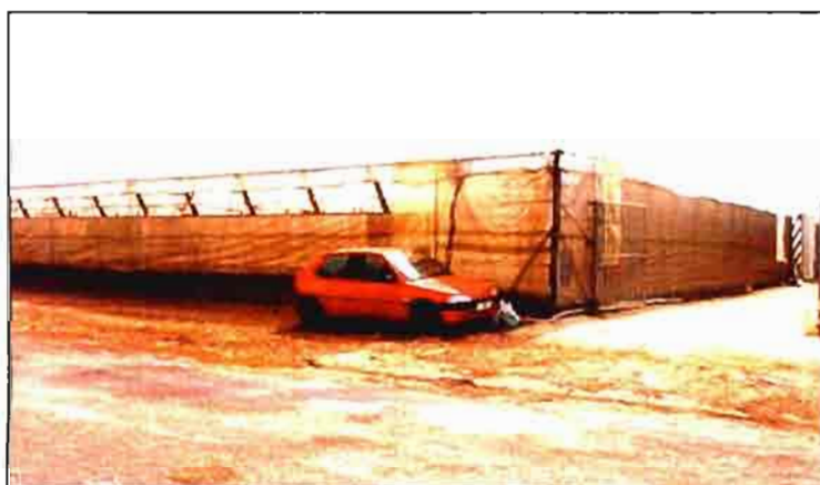
Invernadero de raspa y amagado con film amarillo.
