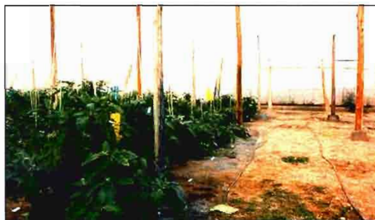
Detalle de invernadero de raspa y amagado con cubierta de plástico amarillo.
