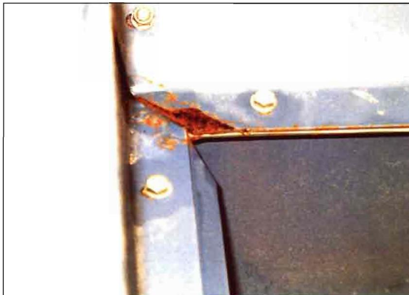
Fig. 5. Detalle de corrosión en una máquina de tres años.
