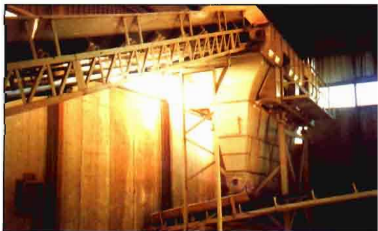
En las nuevas instalaciones se han invertido 3,01 millones de euros.
