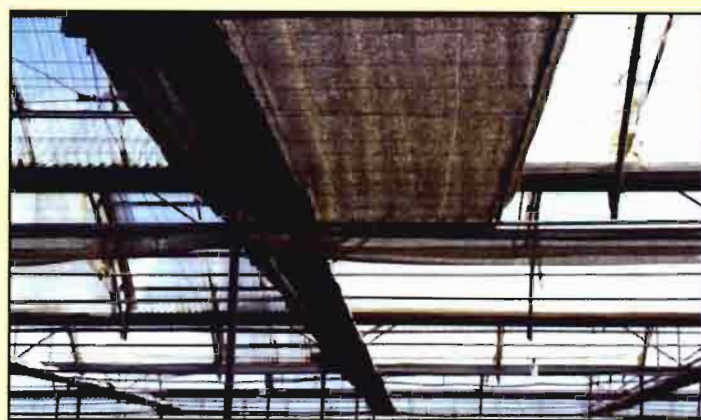
Fig. 9. Pantalla térmica replegada en un sector y en fase de despliegue en el sector contiguo.
