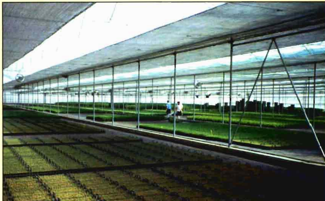
Fig. 6. Invernadero con mallas de sombreo desplegables de forma automatizada.
