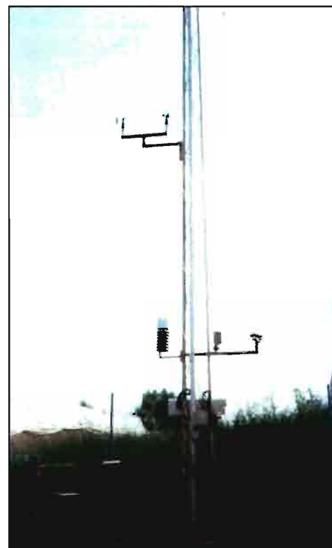
Subestación a 2 metros de altura.
