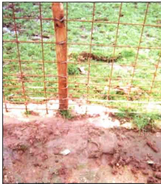
Anclaje en la valla perimetral de mallazo.
