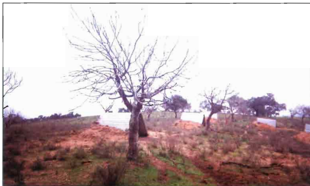
Campings enterrados en su parte inferior para evitar la entrada de agua.
