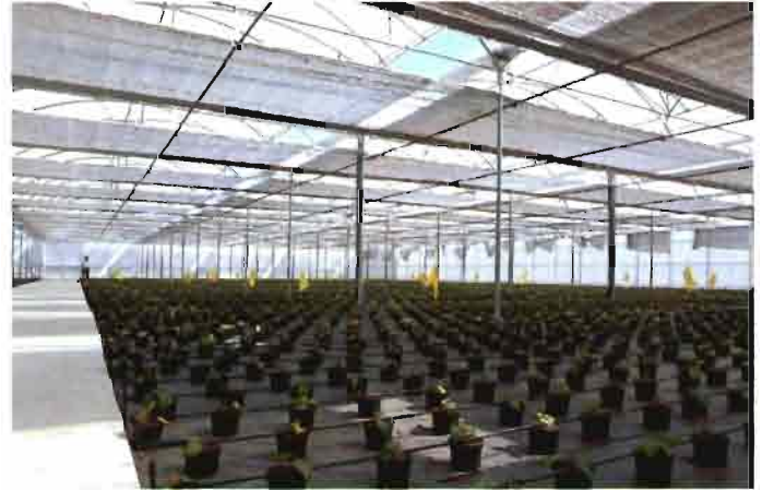
Ventilación cenital y semillero de pantalla térmica en invernadero.
