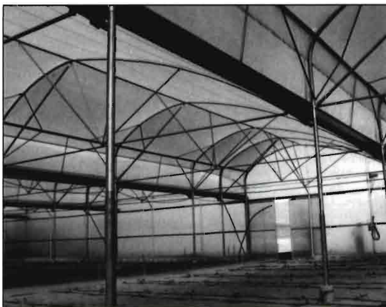
Dos imágenes, exterior e interior, del nuevo invernadero «Superalm» de la compañía Inverca (Invernaderos de Castellón, S.A.L.), un invernadero de diseño asimétrico de la cubierta que permite ampliar la zona de incidencia de la luz solar y aumentar al máximo la luminosidad interior del invernadero.
