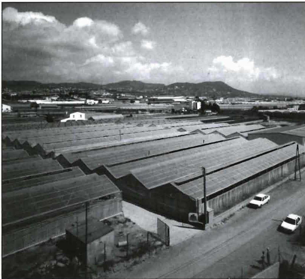
Vista aérea de la explotación Cultius Roig, en el Maresme (Barcelona, España), uno de los productores de planta semi-elaborada de Pelargonium más importantes de Europa. En la imagen se observan invernaderos de placas onduladas de policarbonato.
