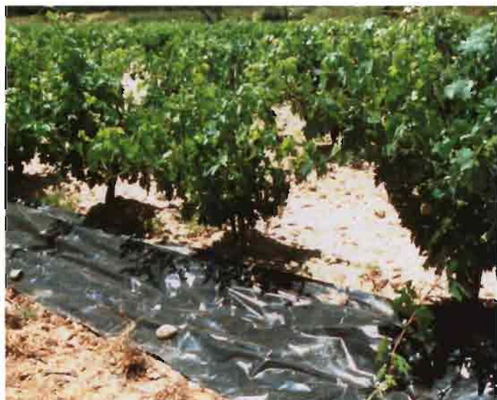
Colocación de cubierta plástica opaca.
