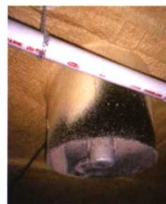
Foto 4. Ejemplo de aislamiento y estanqueidad.
