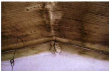
Foto 2. Deterioro del aislante debido a humedades y roedores.
