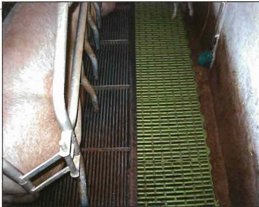
Foto 4. Suelo de paridera con enrejillado metálico y plástico.
