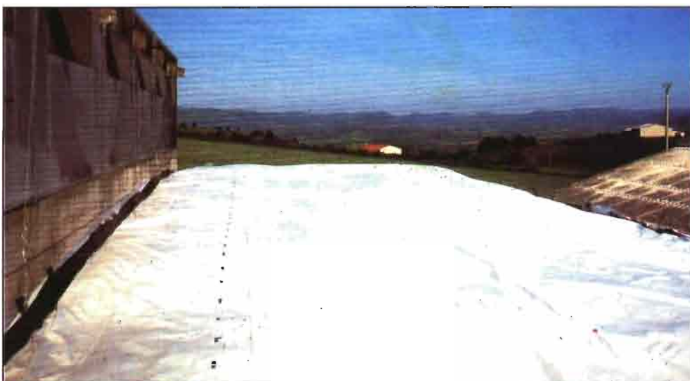
Las láminas se colocan y las bolsas se sitúan alrededor del silo.
