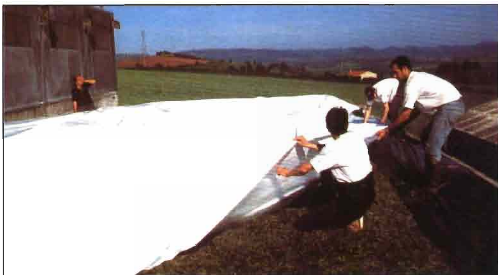
Las dos láminas se extienden juntas.
