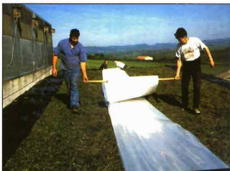
La lámina gruesa se desenrolla sobre la lámina delgada.
