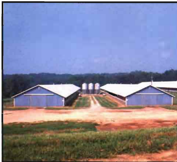
Complejo de naves de ambiente controlado.
