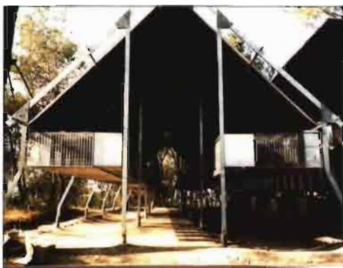
Instalación de un Sistema Open-Air.
