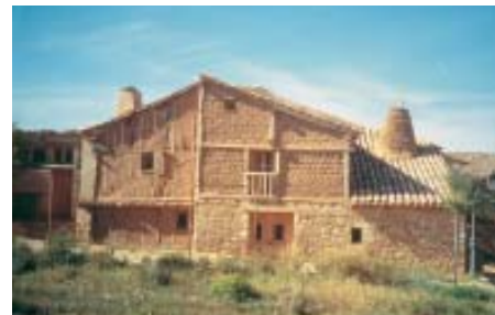
Antes y después en la reconstrucción de una vivienda de Navapalos.
