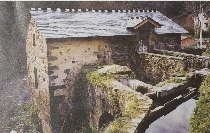
La planta de alevinaje se instalará en un antiguo molino recuperado
