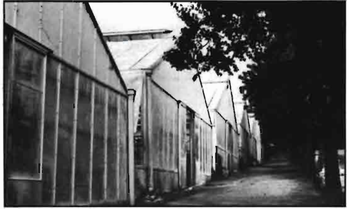
De 1 Ha que tiene la finca los HIBERLUX de INDUSTRIAS IBERIA cubren 3.500 m 2 . El gas ciudad, muy probablemente, sustituirá al gasóleo que alimenta las calderas de calefacción.
