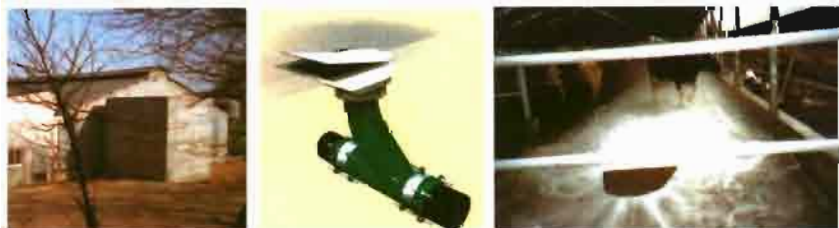
Figura 6. Sistema de limpieza mediante flujo de agua
