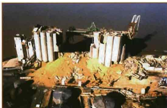
Figura 1. Vista superior de los silos de cereales después de la explosión. BLAYE (Francia) 1997.
