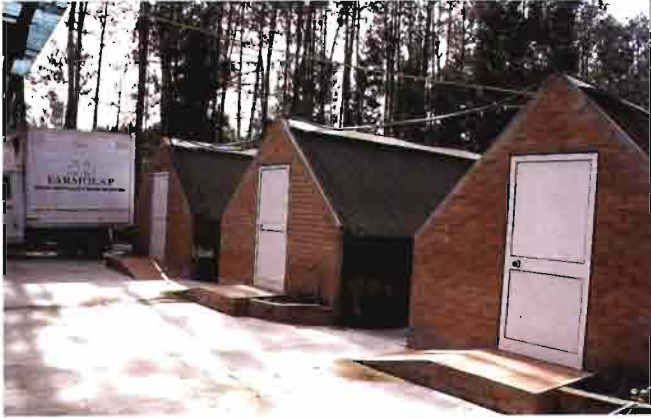
Cabecera de las tres naves Open Air, con su perfecto acabado.
