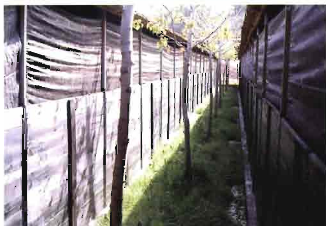
Obsérvese los paramentos verticales construidos en madera.
