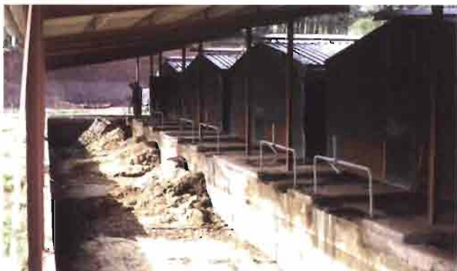
Foso de deyecciones, libre para la recogida mecánica.
