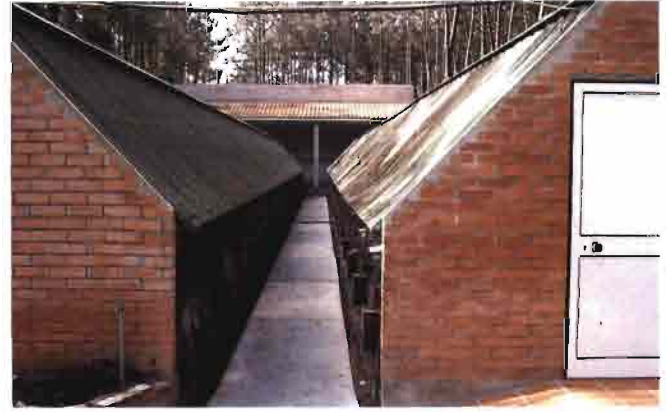
Pasillo de limpieza entre Open Air.
