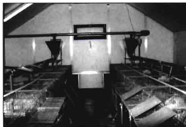
Sistema de distribución por tubo rígido (instalación alimentada por dos tolvas)
