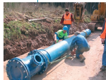
Montaje de un brida-enchufe DN 400 STD VI fuera de la zanja
