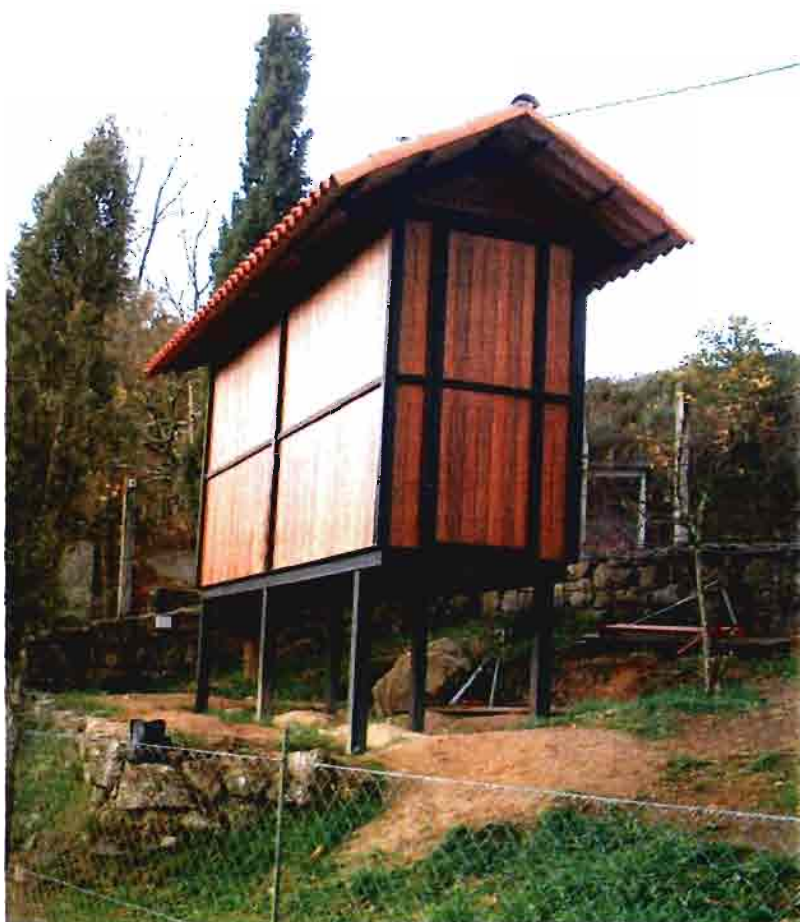
Versión actualizada de hórreo tradicional gallego, hecho de acero y madera
