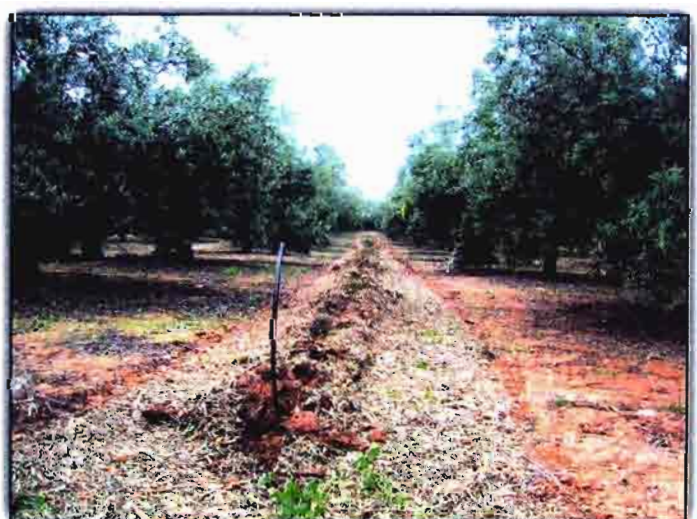
Vista del olivar una vez enterrada la tubería en el centro de la calle de plantación.
