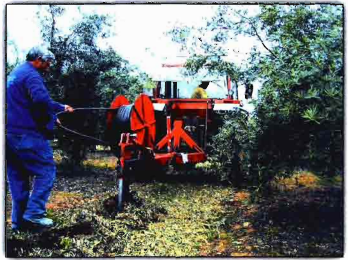
Apero con el que se enterró la tubería en el tratamiento con riego subterráneo. El subsolador localiza la tubería con el gotero integrado a 30 cm de profundidad en el centro de la calle de plantación.
