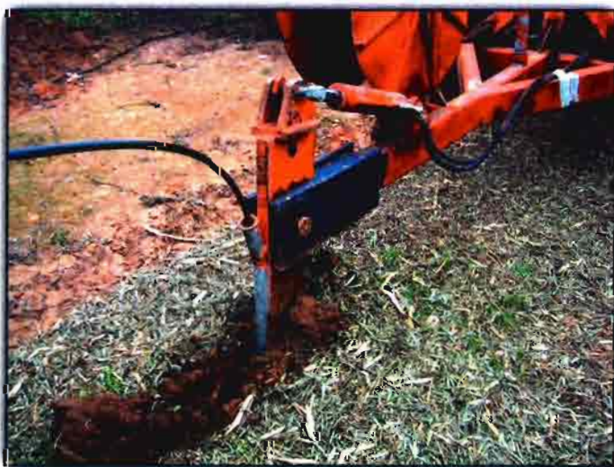
Detalle del trabajo de enterrado de la tubería de riego.
