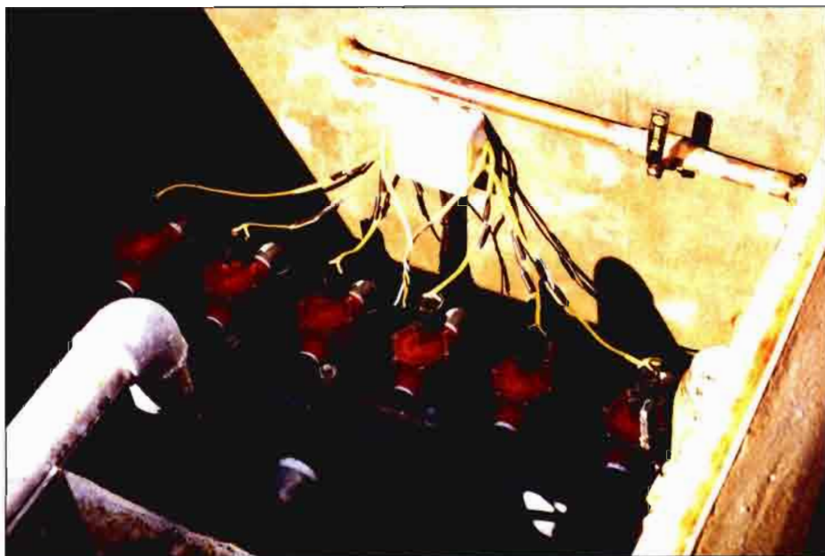
Disposición de electroválvulas para el fraccionamiento de la superficie a regar y adecuación de la demanda a la oferta solar.
