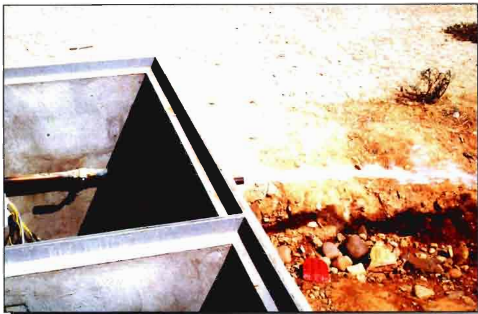
Salida de agua bombeada desde un sistema fotovoltaico
