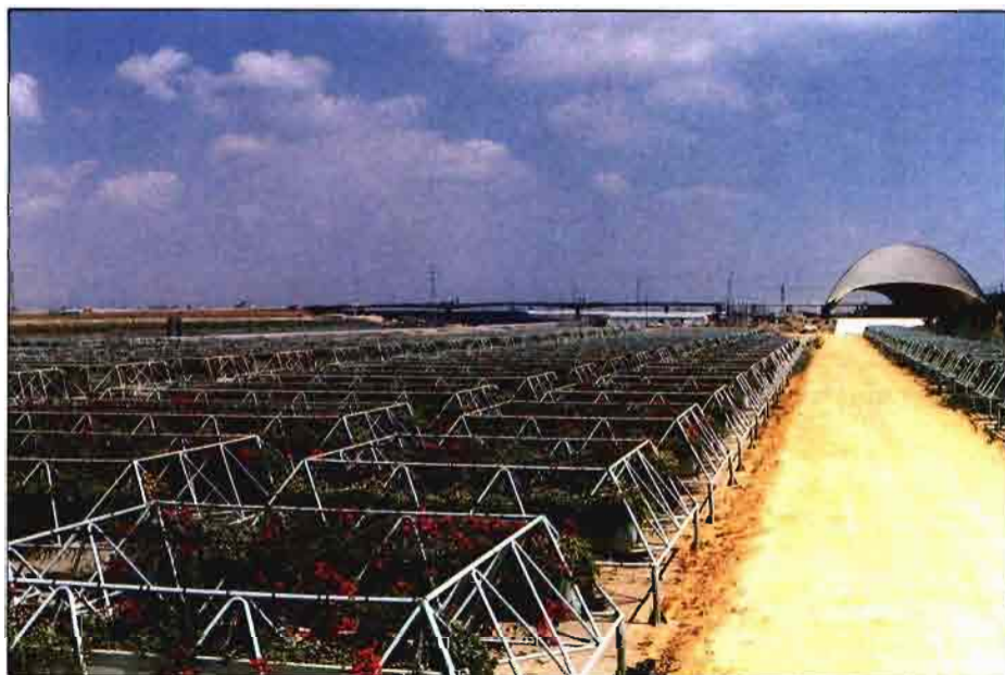
«Vivero» de pérgolas, dispuestas para ser colocadas en el lugar previsto del recinto de la EXPO'92. Estación terminal del TAV al fondo.
