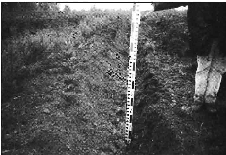
Profundidad de labor. En el fondo de la zanja se aprecia la aparición de arcillas.
