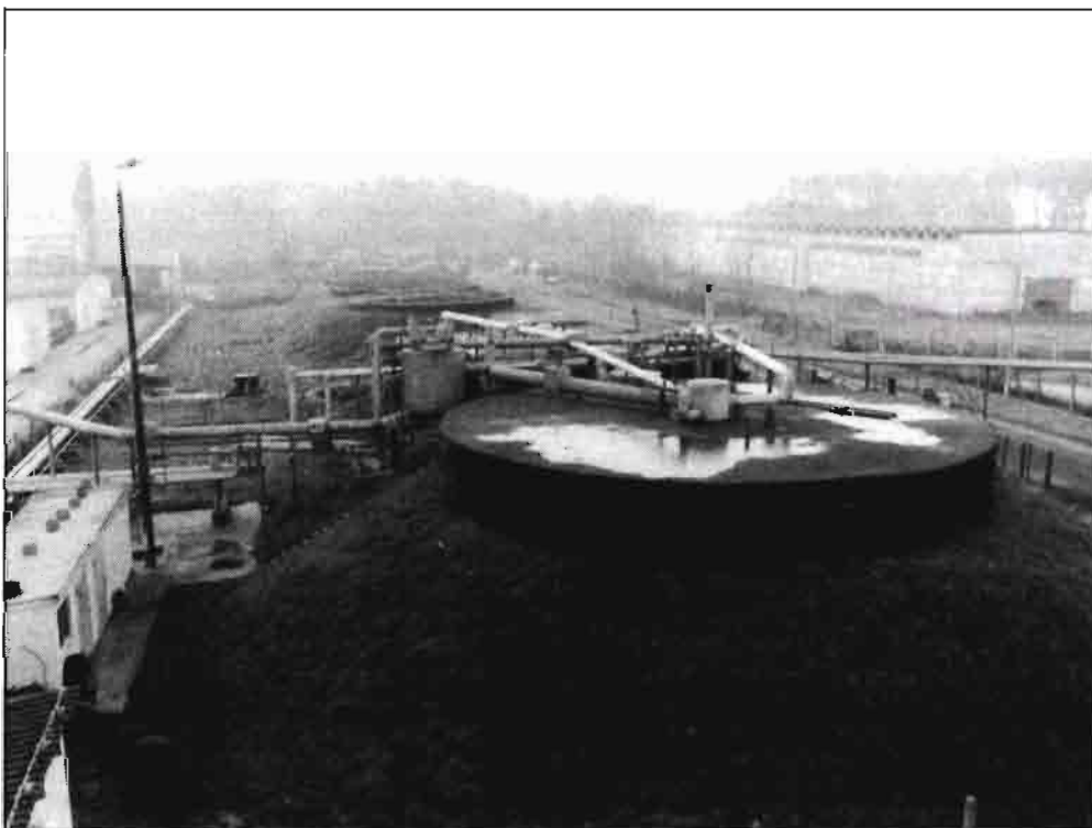
Estación de biogás.
