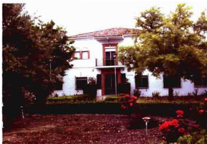
La nueva Estación de Olivicultura, CIFA "Venta del Llano", situada en el término municipal de Mengibar (Jaén).
