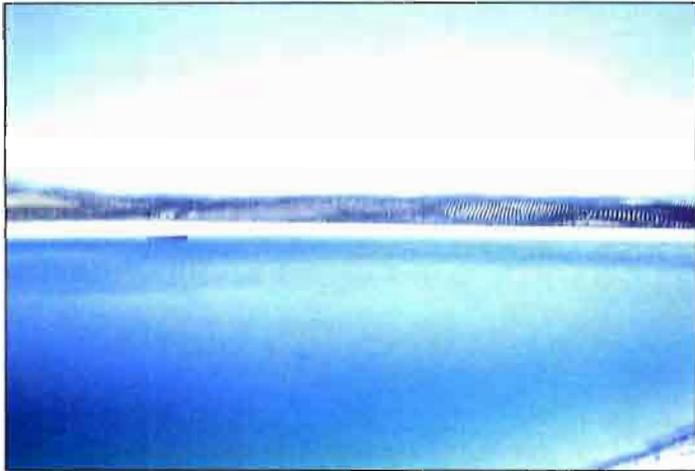
En los riegos con aguas procedentes de los ríos, o aprovechando caudales intermitentes, es normal el empleo de balsas reguladoras de gran capacidad recubiertas interiormente de material impermeable (PVC en este caso), que aseguran el riego durante el verano. Balsa de 400.000 m<sup>3</sup> de capacidad en una comunidad de regantes de Torreperogil que riega 1.600 Has con agua procedente del río Guadalquivir
