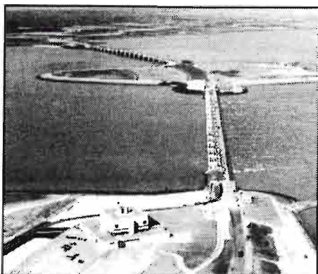
Represa contra temporales en el Escalda Oriental, compuesta por 65 pilares de hormigón, entre los cuales cuelgan 62 compuertas de acero.
