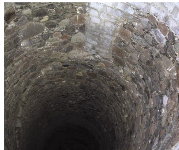
Detalle de pozo profundo tipo canario (fuente: Mancomunidad Intermunicipal del Sureste de Gran Canaria)
