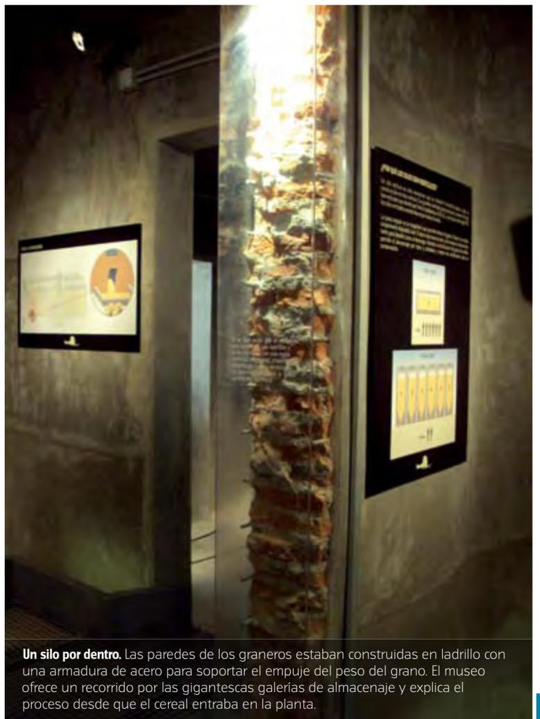
**Un silo por dentro.** Las paredes de los graneros estaban construidas en ladrillo con una armadura de acero para soportar el empuje del peso del grano. El museo ofrece un recorrido por las gigantescas galerías de almacenaje y explica el proceso desde que el cereal entraba en la planta.
