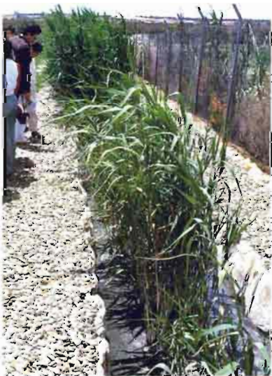
Fig. 9.- Depuración de aguas residuales mediante plantas emergentes. P.E. Carrión de los Céspedes.
