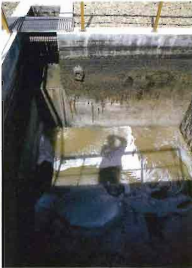
Fig. 2.- Las aguas residuales brutas deben ser sometidas a los tratamientos oportunos antes de su reutilización. Planta Experimental de Carrión de los Céspedes (Sevilla).
