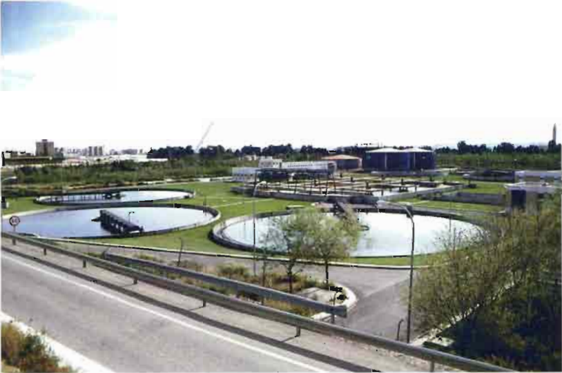
Fig. 1.- Las grandes depuradoras convencionales suponen elevadas inversiones económicas, tanto de instalación como de mantenimiento. E.D.A.R. San Jerónimo (Sevilla).
