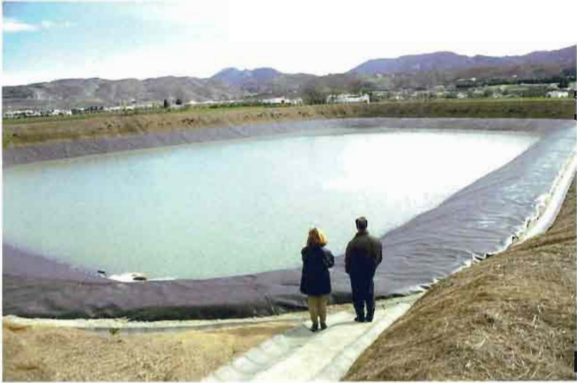
Fig. 8.- Balsa de almacenamiento de agua depurada. E.D.A.R. de Antequera (Málaga).
