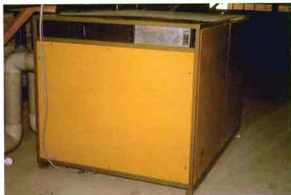
Fig. 10.—Quemador para la eliminación de etileno de las cámaras frigoríficas.
