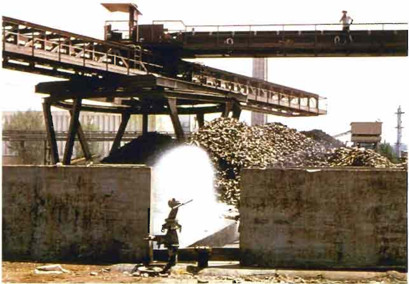
Fig. 1.—Descarga hidráulica de silos de remolacha.
