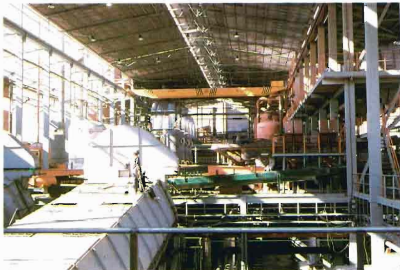
Fig. 3.—Visita parcial del edificio principal de proceso.
