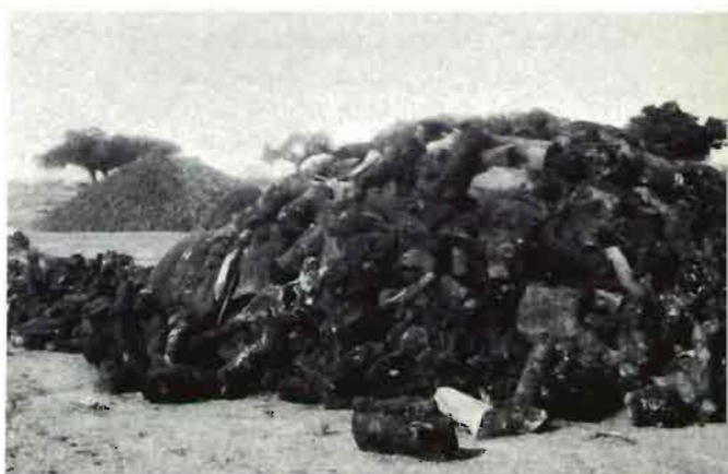
Fig. 1.—Delante, encañado de la carbonera o capa formada por troncos gruesos. Al fondo, carbonera cubierta con la tercera capa de ramas finas.
