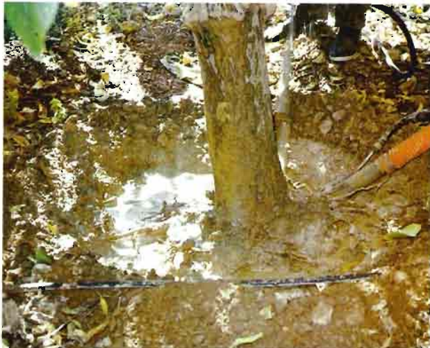
Fig. 10.—Moderno sistema de escarbado hidráulico de troncos y raíces.
