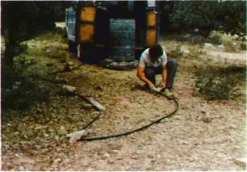
Fig. 3.—Operación de instalación del riego por goteo.
