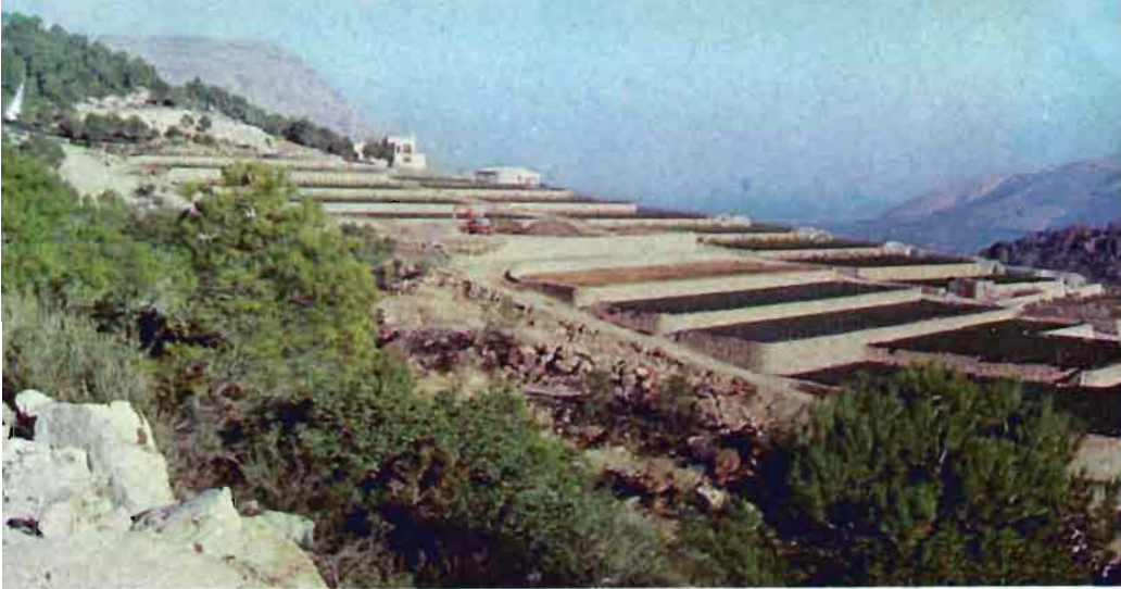
Fig. 12.—Transformación de monte bajo en regadío con construcción de bancales.
