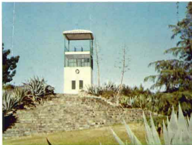
Fig. 1.—Torre de vigilancia contra incendios forestales.
